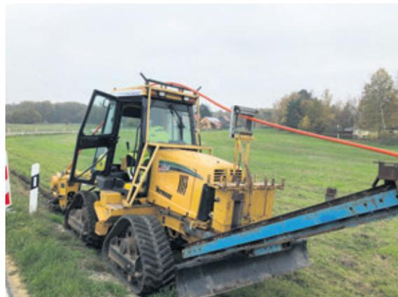
Der Boden wird dabei mit Hilfe einer Vorrichtung aufgeschnitten. Das Kabel, welches verlegt werden soll, ist schon an der Schneidvorrichtung befestigt und wird somit im gleichen Arbeitsgang in den Boden eingezogen. Im Anschluss wird die schmale Bodenöffnung wieder verschlossen. Manchmal ist dies aber auf Grund der Bodenbeschaffenheit gar nicht nötig.
