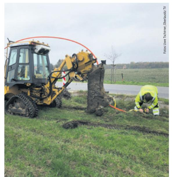
Der Vorteil dieses Verlegeverfahrens ist, dass es ohne gravierende Einschnitte in die Natur erfolgt. Darüber hinaus können bei Bedarf mehrere Kabel und/oder Rohre gleichzeitig in einem Arbeitsgang mit hohen Tagesleistungen verlegt werden.
