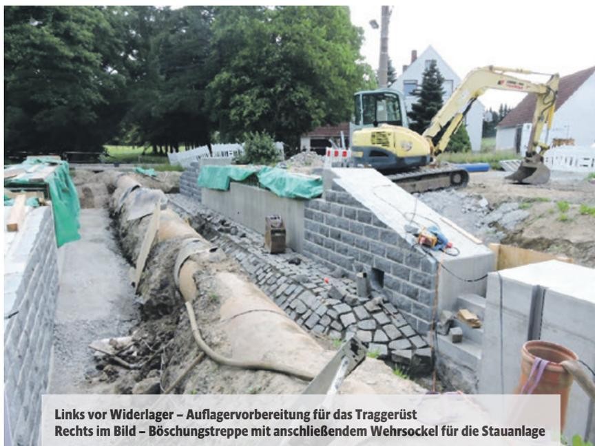
Links vor Widerlager – Auflagervorbereitung für das Traggerüst
