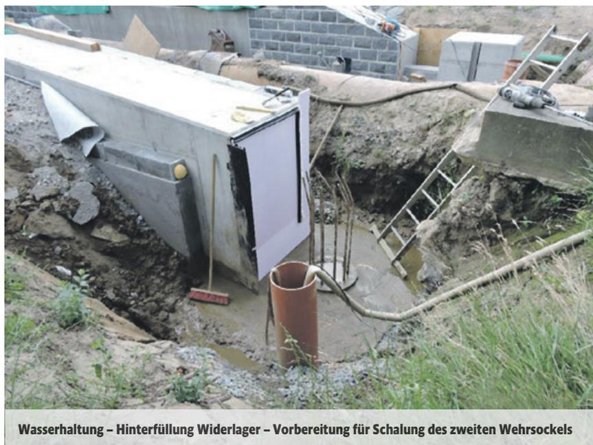
Wasserhaltung – Hinterfüllung Widerlager – Vorbereitung für Schalung des zweiten Wehrsockels
