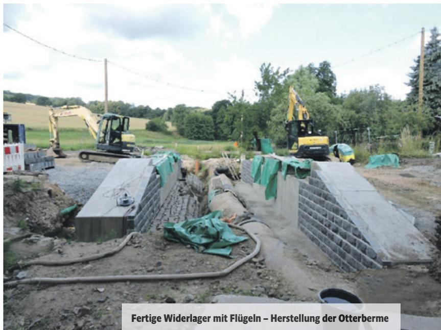
Fertige Widerlager mit Flügeln – Herstellung der Otterberme
