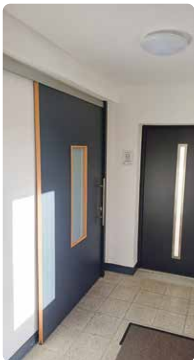
Einbau einer behindertengerechten Schiebetür im Gemeindevereinshaus Bulleritz im Förderjahr 2025
