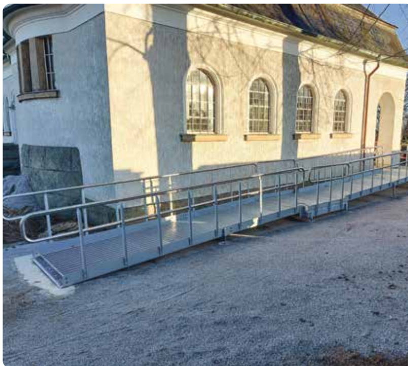
Katholische Dompfarrei „St. Petri“ Bautzen, „Errichtung eines barrierefreien Zugangs zur Kapelle auf dem Friedhof St. Marien in Bautzen“ im Förderjahr 2021
