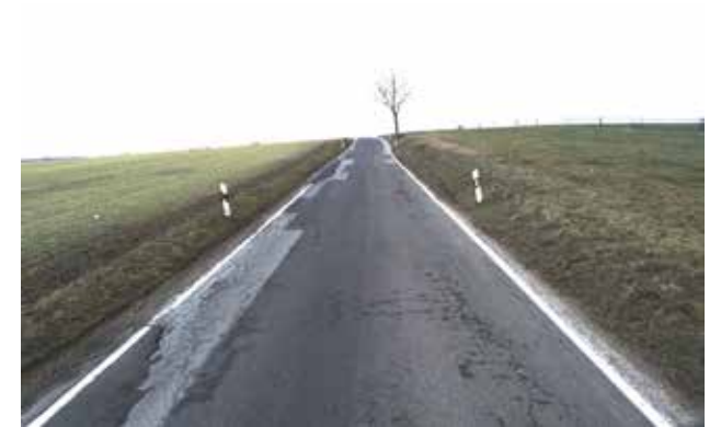
K 9252 Richtung Ottendorf-Okrilla: fehlende Bankette, Entwässerung der Felder auf die Kreisstraße
