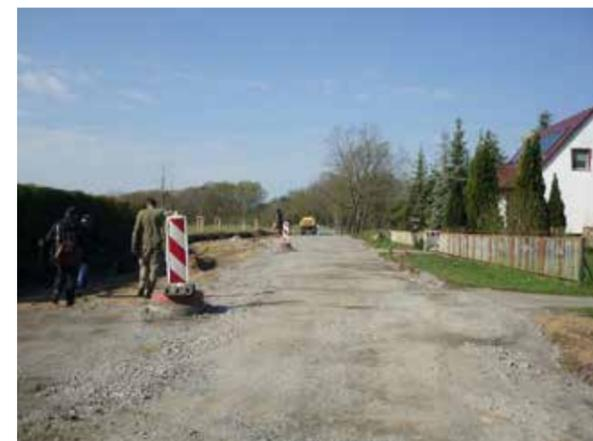
der Asphaltfahrbahn wurde zudem die Baufreiheit für die Verlegung der neuen Trinkwasserleitung geschaffen, welche parallel mit der Regenwasserleitung in die Erde gebracht wurde. Daran schließen sich der
