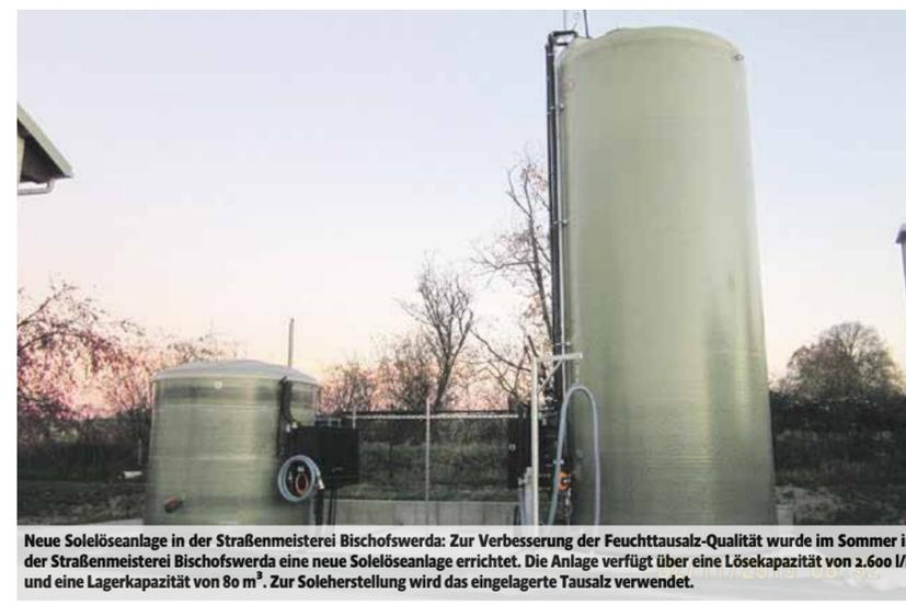
Neue Solelöseanlage in der Straßenmeisterei Bischofswerda: Zur Verbesserung der Feuchttausalz-Qualität wurde im Sommer in der Straßenmeisterei Bischofswerda eine neue Solelöseanlage errichtet. Die Anlage verfügt über eine Lösekapazität von 2.600 l/h und eine Lagerkapazität von 80 m³. Zur Soleherstellung wird das eingelagerte Tausalz verwendet.
