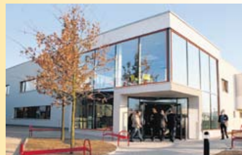
Das POLYSAX Technikum wurde von der OBAG Hochbau GmbH gebaut und von der AIB GmbH in Passivhaus-Bauweise geplant
