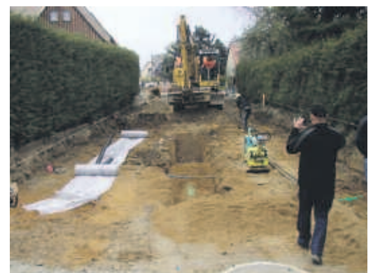
Im September soll der Bau der Kreisstraße abgeschlossen sein.
