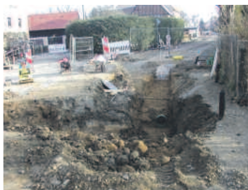
Kreisstraßenbau mit Leitungsverlegung und Arbeiten am Regenwasserkanal
