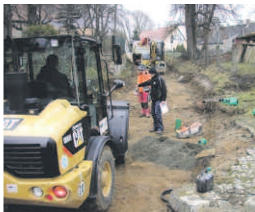
Bau der Dorfstraße in Zschorna
