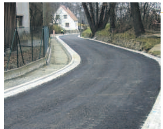
Die Dorfstraße nach Fertigstellung des 1. Bauabschnitts
