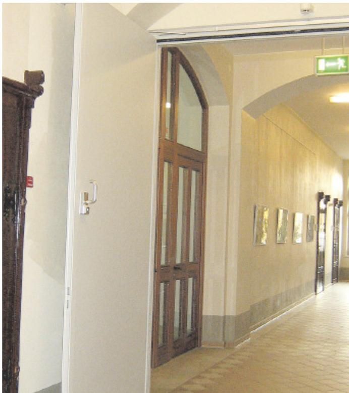
Im Zuge der Brandabschnittsbildung im Erweiterungsbau wurden neue Brandschutztüren montiert.
