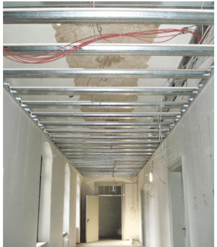
Die neue Deckenunterkonstruktion des Flurbereiches wirkt brandhemmend und dient gleichzeitig als Kabelkanal.
