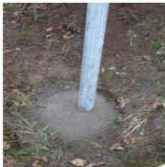
Betonfundament in Erdreich
