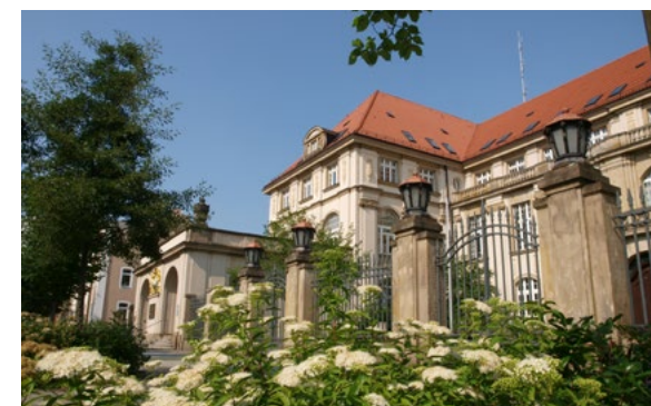
Landratsamt Bautzen, Bahnhofstraße 9
