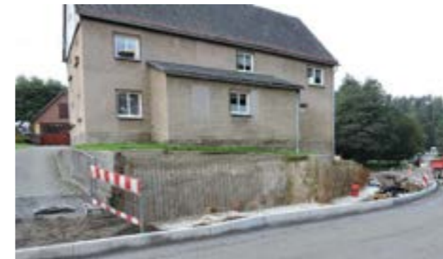
Stützwand- und Böschungssicherung durch Rückverankerungen © Landkreis Bautzen
