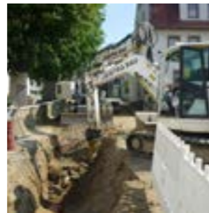
Arbeiten im Felsgestein © Landkreis Bautzen
