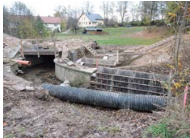
Reinigung der Natursteinflächen © Landkreis Bautzen
