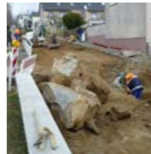
Kanal- und Leitungsarbeiten © Landkreis Bautzen
