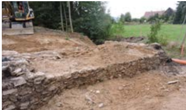
Freilegung des Gewölbes © Landkreis Bautzen
