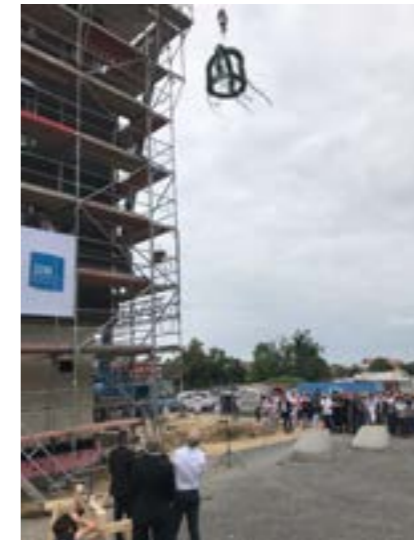
Coronabedingt erhielt der Erweiterungsneubau erst im Juli seine Richtkrone.
