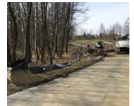
Brückenbau © Landkreis Bautzen
