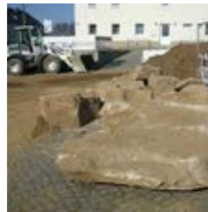
Beim Leitungsbau geborgene Findlinge © Landkreis Bautzen
