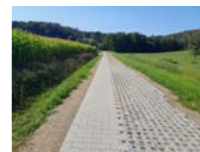
Weg zum Teich nach dem Ausbau © Teilnehmergeinschaft Wehrsdorf
