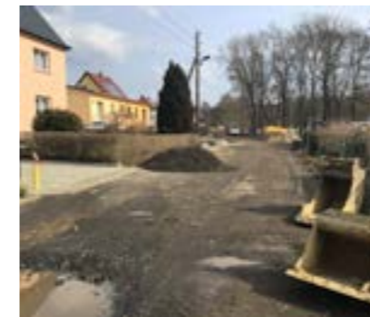
Straßenbau in der Ortslage Seeligstadt © Landkreis Bautzen
