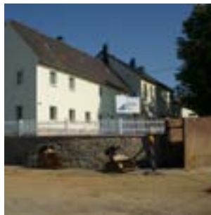
Neu errichtete Stützwand an der Kreuzung Bergstraße/Neukircher Straße/Dorfstraße © Landkreis Bautzen
