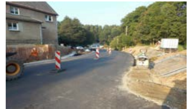
Straßenbauarbeiten zur Neugestaltung der Verkehrsanlage © Landkreis Bautzen
