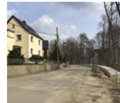
Herstellung Stützmauer © Landkreis Bautzen
