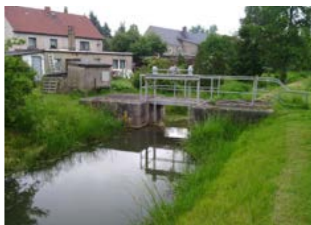
Wehr an der Gruna © Ingenieurbüro Krämer
