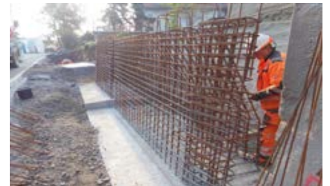
Schal- und Bewehrungsarbeiten für Stützwand © Landkreis Bautzen
