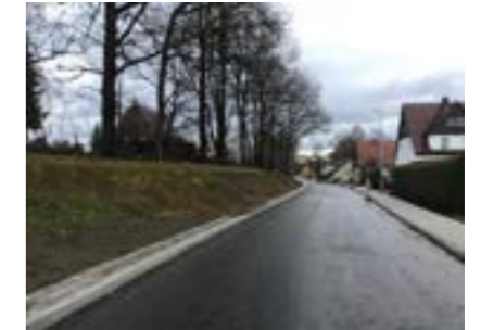
Straßenbau teilweise abgeschlossen (außer Asphaltdeckschicht und Nebenanlagen) © Landkreis Bautzen
