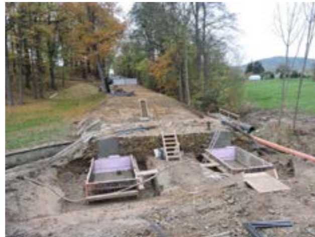
Schalung für die Fundamente © Landkreis Bautzen
