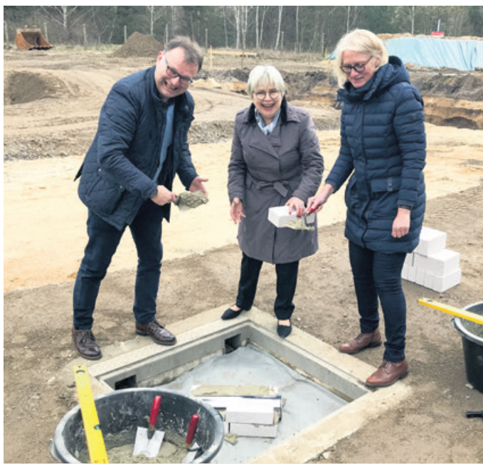
Symbolisch Grundsteinlegung durch die Beigeordneten Birgit Weber, Sigline Rauch-Liebig vom Sächsischen Staatsministerium für Wirtschaft, Arbeit und Verkehr und dem Bürgermeister Heiko Driesnack.
