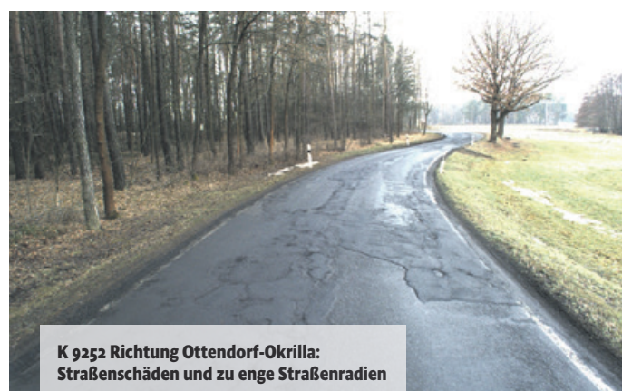
K 9252 Richtung Ottendorf-Okrilla: fehlende Bankette, Entwässerung der Felder auf die Kreisstraße
