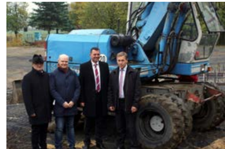
V.l.n.r.: Roland Dantz (Oberbürgermeister von Kamenz), Stefan Cyriax (Schulleiter der 2. Oberschule Kamenz), Udo Witschas (Erster Beigeordneter des Landrates) und Aloysius Mikwauschk (Mitglied des Sächsischen Landtages) freuen sich über den Baustart zur Erweiterung der 2. Oberschule Kamenz.
