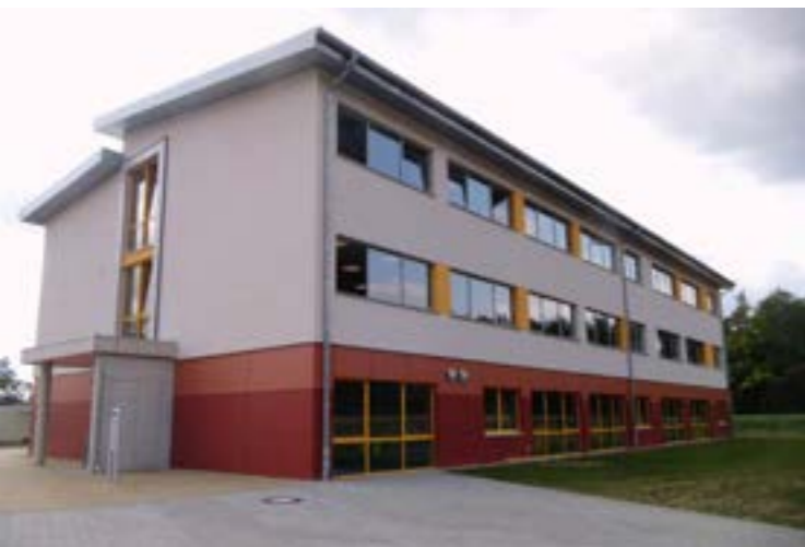
Am 27.06.2018 wurde der Erweiterungsbau der Oberschule Königsbrück eingeweiht.
