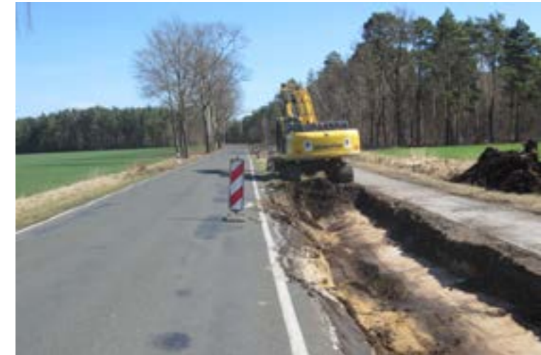
Ausbaggerung der Bankette für die Erstellung eines tragfähigen Unterbaus in Höhe Ortsausgang Maukendorf
