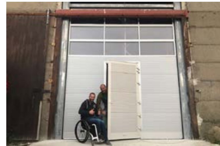
Offroad-Travel e. V. Radeberg: Barrierefreier Zugang zur Selbsthilfeworkstatt durch den Einbau eines elektrischen Rollltores.
