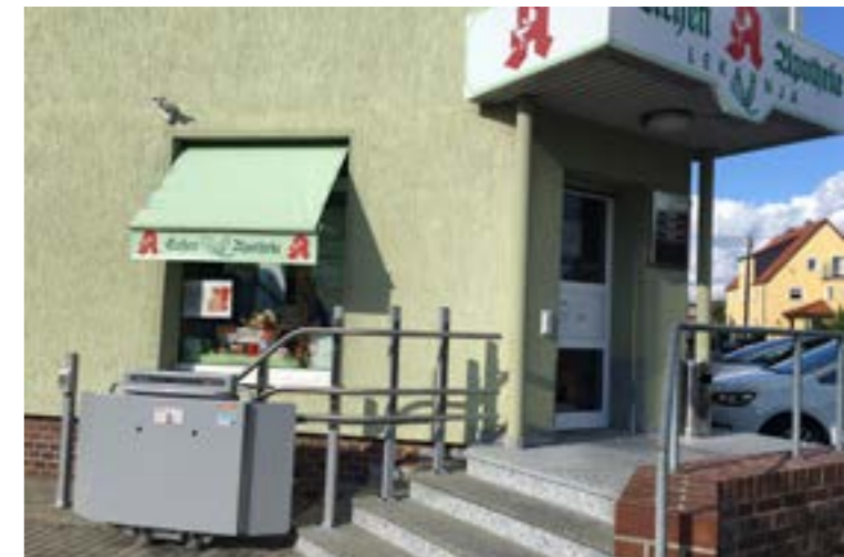
Eichen-Apotheke Großdubrau: Barrierefreier Zugang durch Anbau eines Treppenliftes.
