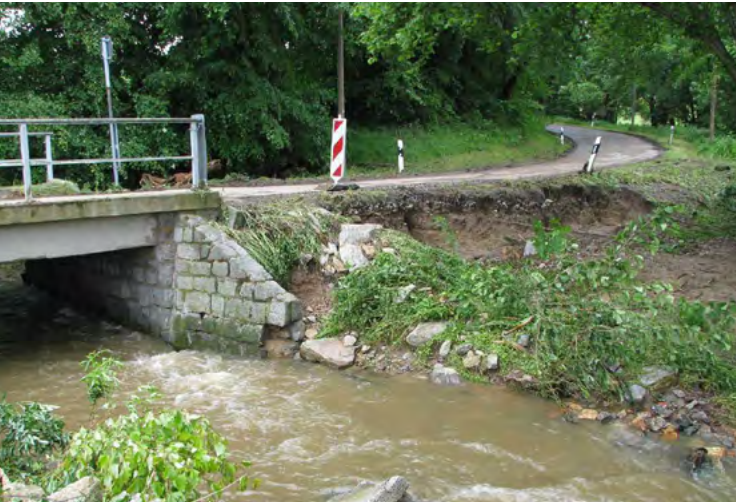
K 7227 Brückenbauwerk 2 bei Rodewitz
