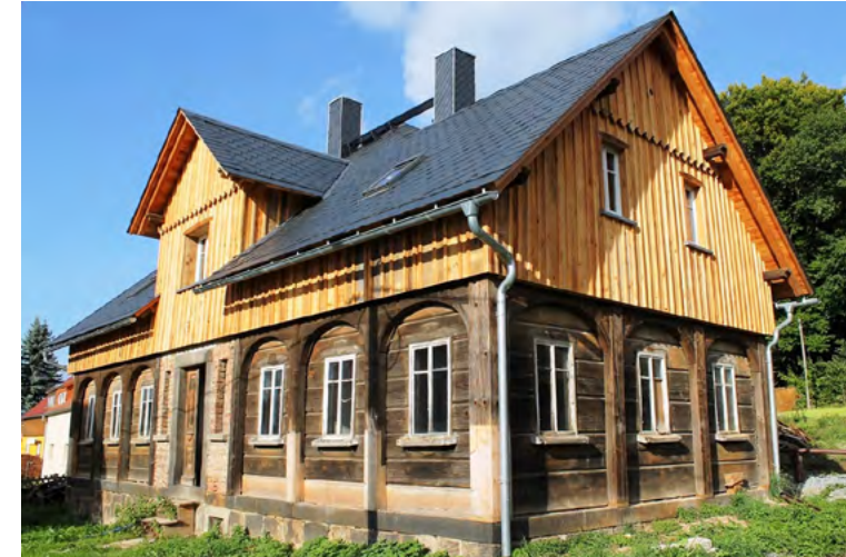
Die Stiftung Umgebindehaus fördert vor allem die behutsame Instandsetzung der historischen Bausubstanz. Durch intensive Beratung des Bauherren ist dies sichtbar gelungen.
