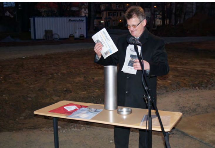
Schulleiter Uwe Richter befüllt zur feierlichen Grundsteinlegung eine Metallhülle nach gutem alten Brauch mit Zeitzeugen, wie einer Tageszeitung, dem Amtsblatt des Landkreises Bautzen, einem kompletten Euro-Münzsatz, Bauplänen und einer Statistik zu Schüler- und Klassenzahlen.
