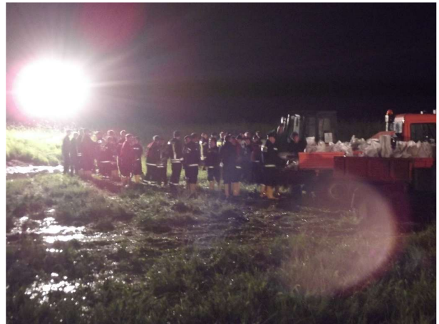
Nächtlicher Sandsackverbau am Deich bei Zeißig. Ca. 120 Einsatzkräfte der Feuerwehren, der Feuerweherschule Nardt und Helfer hatten über 60.000 Sandsäcke gefüllt und verbaut, um den Deich zu stabilisieren
