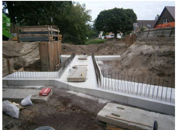
Unterbau: Bodenplatte vor dem Einbau der Wandschalung
