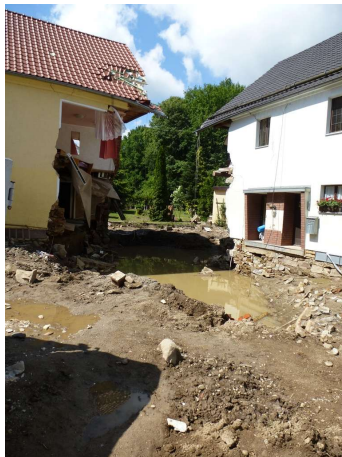
(li.) Das Kotitzer Wasser hatte in Kleinzschorna, Gemeinde Hochkirch, Teile eines Hauses wegerissen: (re) in Kuppritz hatten Straßenbrücke und Uferböschung keine Chance
