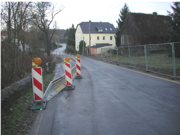
K 9257 Grünberg: In Grünberg musste als Folge des Juni-Hochwassers die Befahrbarkeit der Straße wiederhergestellt werden. Hierfür wurde eine Stützmauer errichtet.
