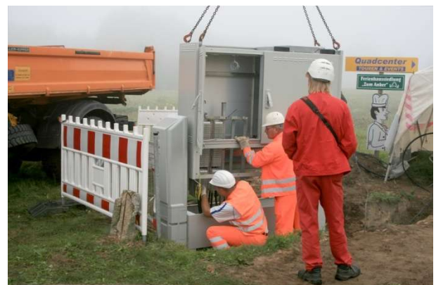
Techniker bei der Montage eines Multifunktionsgehäuses bei Klein Partwitz
