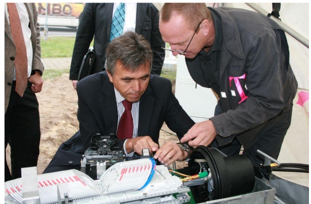
Telekom-Monteur Frank Kockott erläutert dem Landrat die Grundzüge des Glasfaserschweißens
