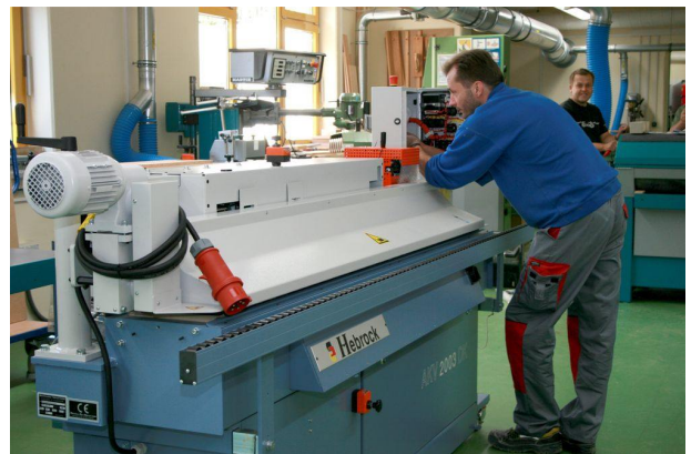
Die Fa. Mickel-Elektro GmbH führt die notwendigen Elektroinstallationen für die Kantenleimmaschine aus.
