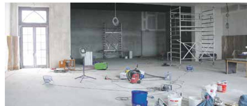
Der Saal des SNE im Umbau.
