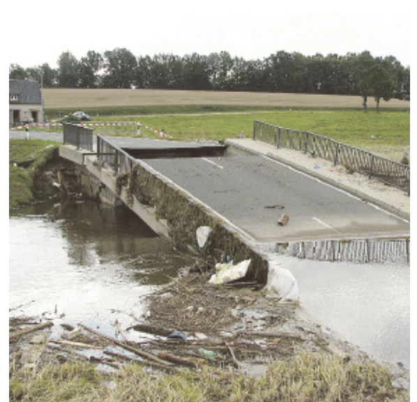
Am 24. Oktober 2011 haben die lang erwarteten Arbeiten zum Brückenbau in Sohland begonnen (Foto links, Foto Mitte: Stahlbewehrung für das Brückenbauwerk). Die Brücke auf der B 98 wurde durch das Hochwasser im August 2010 vollkommen zerstört (Foto rechts), die Bundesstraße nicht mehr nutzbar. Die untere Darstellung zeigt, wie die Brücke nach Beendigung der Arbeiten im August 2012 aussehen soll.
