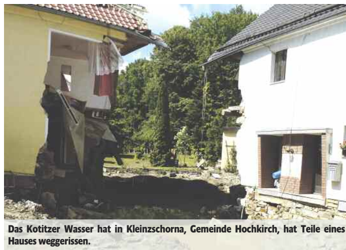
In Kuppritz, Gemeinde Hochkirch, hatten Straßenbrücke und Uferböschung keine Chance.
