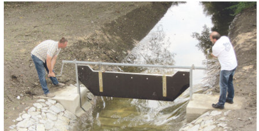
«Wasser marsch» – Bürgermeister Steffen Grahl nimmt das Wehr wieder in Betrieb.
