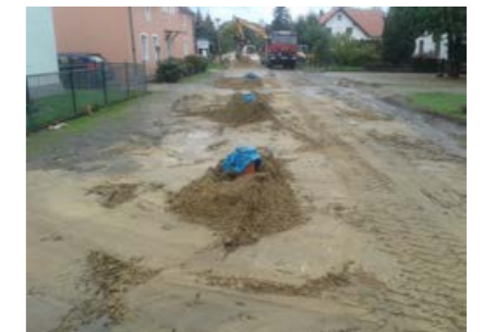
Verfüllter Rohrgraben der Trinkwasserleitung, ©Landkreis Bautzen
