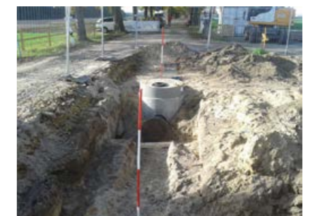
Verlegung des Regenwasserkanals, ©Landkreis Bautzen
