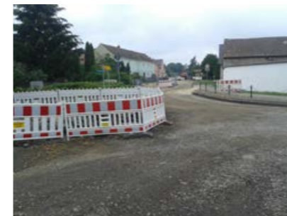
Kreuzung Elsterstraße/Lindenstraße nach Abbruch der Asphaltdecke, ©Landkreis Bautzen
